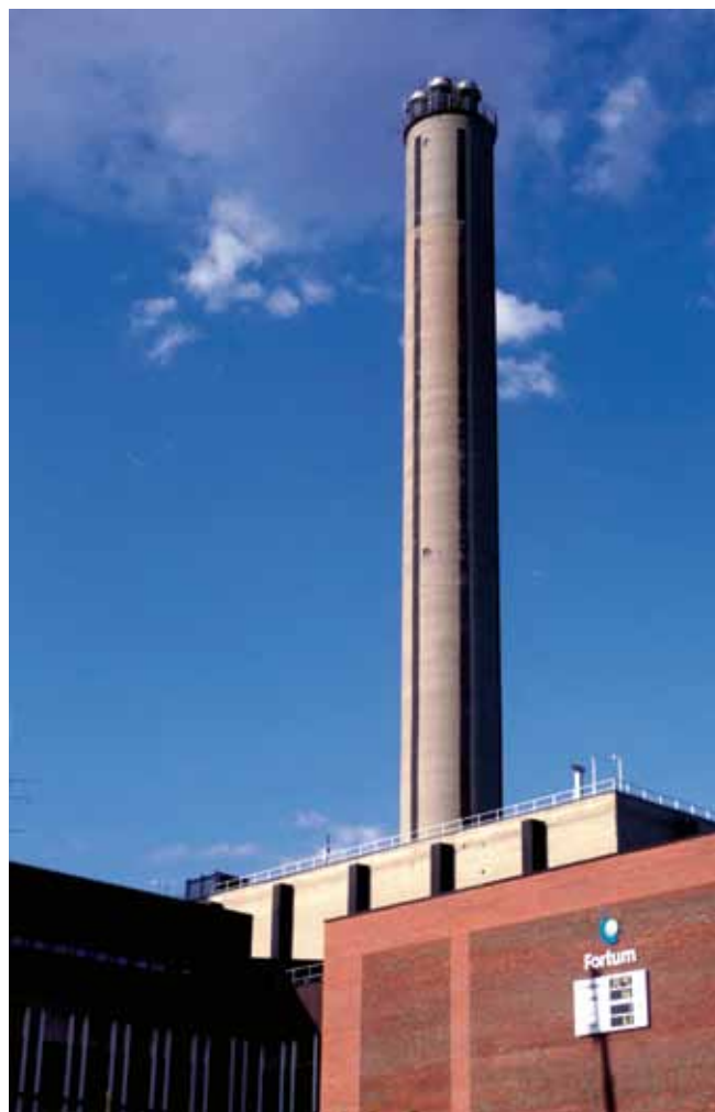
Fortums fjärrvärmeverk i Värtahamnen i Stockholm. Koleldningen här står för lika mycket koldioxidutsläpp som all biltrafik i hela Stockholm. Det hör man sällan nämnas i fjärrvärmedebatten.
