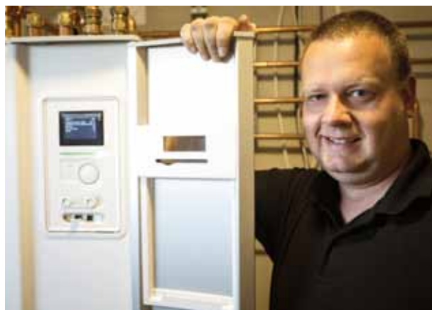
– Elen kommer ju inte att bli billigare med åren, så jag ville passa på att satsa på solens gratisvärme när vi ändå byggde, säger Joakim Wulf i Hjärnarp. Joakim värmer upp 270 kvm med en NIBE F2026 luft/vattenvärmepump, 3 st 24 rörs IntelliHeat solpaneler, NIBE VVM 500 Innedel.
